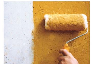
Le revêtement (plâtre / simple couche) doit être appliqué sur le Topfix sèche et collante (environ 30 minutes après l'application de Topfix, selon la météo).
